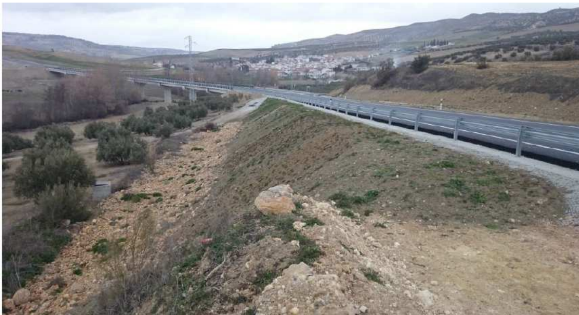
Figura 2 – Taludes seleccionados para instalar el sistema de control avanzado ( Fuente: CHM )
